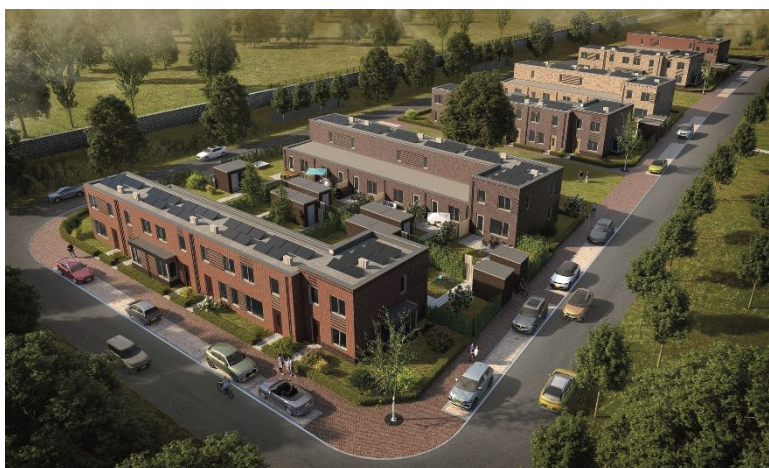
Nieuwbouw Op de Brik, Reuve
