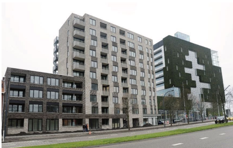
Nieuwbouwproject Traverse, aan Eindhovenseweg te Venlo
